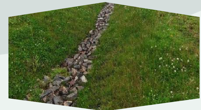
Zanjas de infiltración. Fuente: Ferguson et al. (2020)
