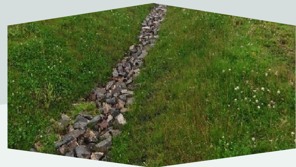
Fossati di infiltrazione. Fonte: Ferguson et al. (2020)
