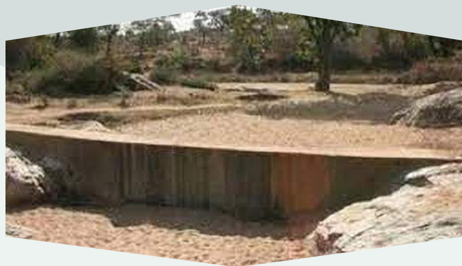
Diga a secco. Fonte: Green Tec Irrigation
