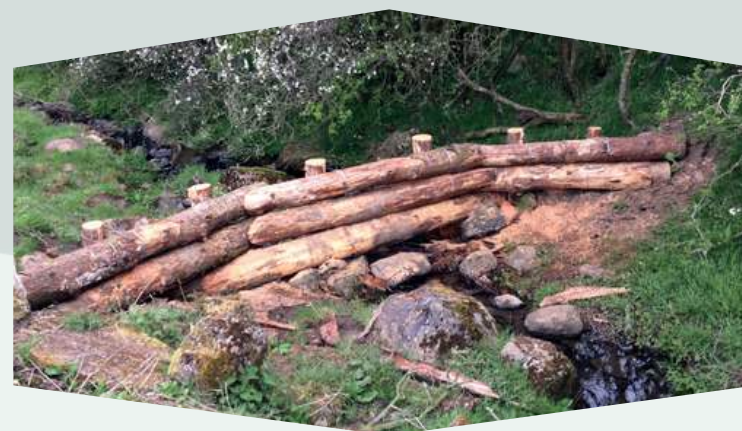
Barragens permeáveis. Fonte: The Flood Hub
