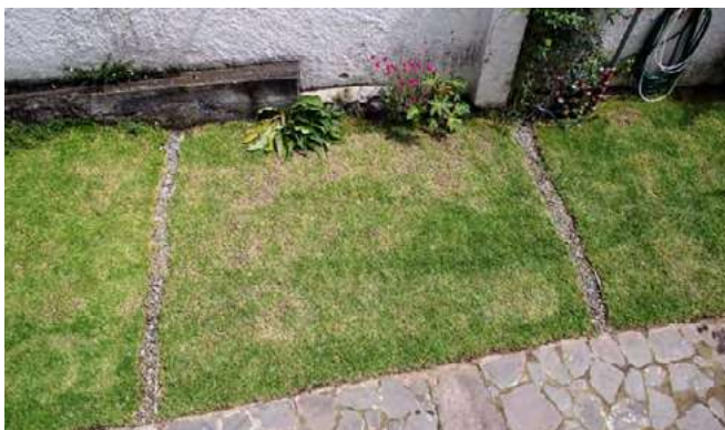
Figura 19. Sistema de infiltración, Casa Armero (YES Innovation, 2019).
