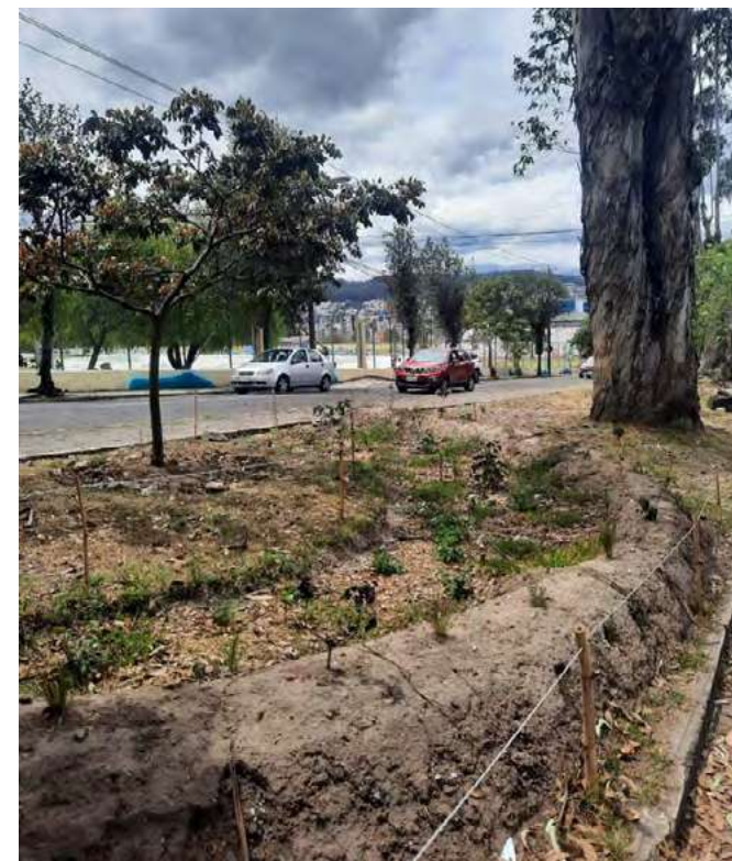
Figura 20. Jardines de Lluvia implementados en el parterre central de la Av. Maria de Jesus (Photos: YES Innovation, 2022).
