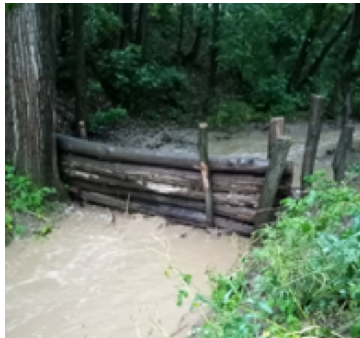
38. ábra: Püspökszilágyi rönkgátak száraz időszakban és „munka” közben. (Fotó: Belügyminisztérium, Püspökszilágy Község Önkormányzata)
