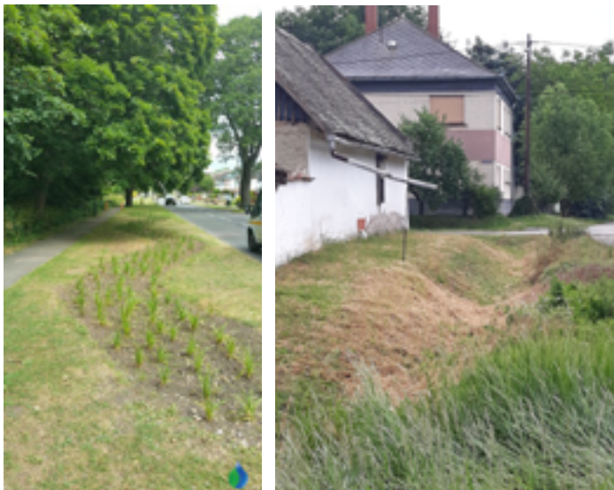
7. ábra: Balra: vízbeszivárogtató zöldfelület Észak-London egy modern lakónegyedében. (Forrás: www.susdrain.org ) Jobbra: hagyományos szikkasztóárkok egy síkvidéki magyar településen. (Fotó: Farkas Viktor Mátyás, WWF Magyarország)
