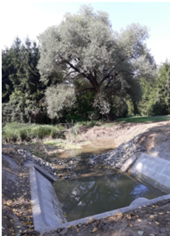
59. ábra: Hordalékfogó aknák kialakítása Püspökszilágy záportározójához. (Fotó: Farkas Viktor Mátyás, WWF Magyarország.)
