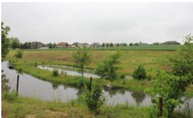
9. ábra: A csehországi Hostovice településen egy belterületi patakszakasz kanyarulatainak visszaállításával és ártere ellaposításával érték el az árvízveszély csökkenését, és hoztak létre egy vonzó parkot a korábbi kanális helyén. (Fotó: Farkas Viktor Máttyás, WWF Magyarország)
