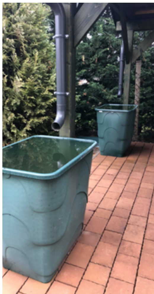
22. ábra: Egyszerű és olcsó csapadékgyűjtő-rendszer telken belüli csapadék megtartására és hasznosítására. (Fotó: Szabó Zsófia, Bátya Község Önkormányzata)
