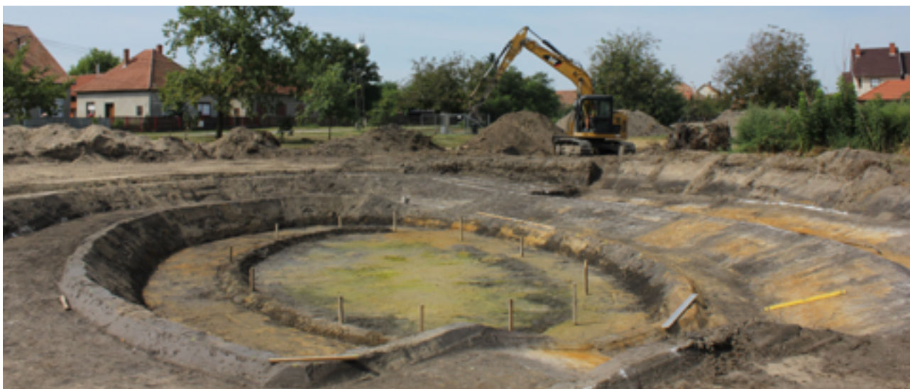
57. ábra: Sokszínű, szabálytalan medergeometria kialakítása Ruzsán. A lapos részsűk és többszintes padkák váltogatták egymást, melyek kialakítása több odafigyelést és munkát igényel a kivitelezőtől, és a legmeredekebb részsű alkalmazásához képest csökkenti a meder víztározó térfogatát is. Azonban a lapos partoldal egyszerre biztonságos, és nyújt sokszínű élőhelyet a vízi élővilág megtelepedéséhez. (Fotó: Farkas Viktor Mátyás, WWF Magyarország)
