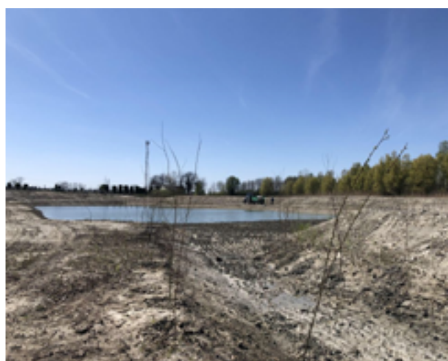
29. ábra: Kivitelezési földmunkák Bátorfajanoson (2020. I. negyedév). (Fotó: Szabó Zsófia, Bátorfajanos Község Önkormányzata)
