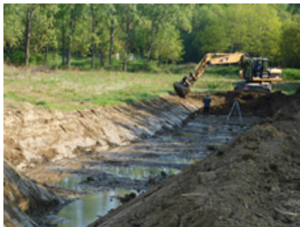
36. ábra: Kivitelezési munkák Püspökszilágyon (Fotó: Püspökszilágy Község Önkormányzata)
